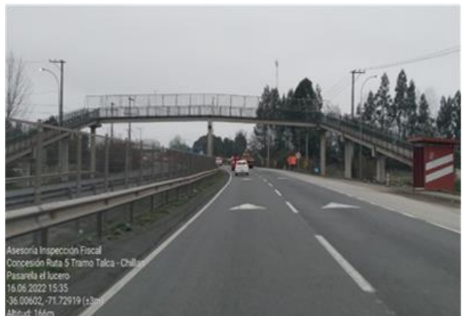
Pasarela Lucero (Km 322,152)
