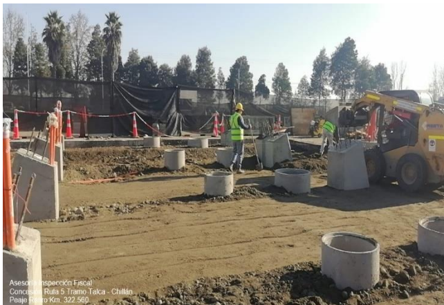
Obras Sistema de Cobro Electrónico en Peaje Retiro (Km 322,560)
