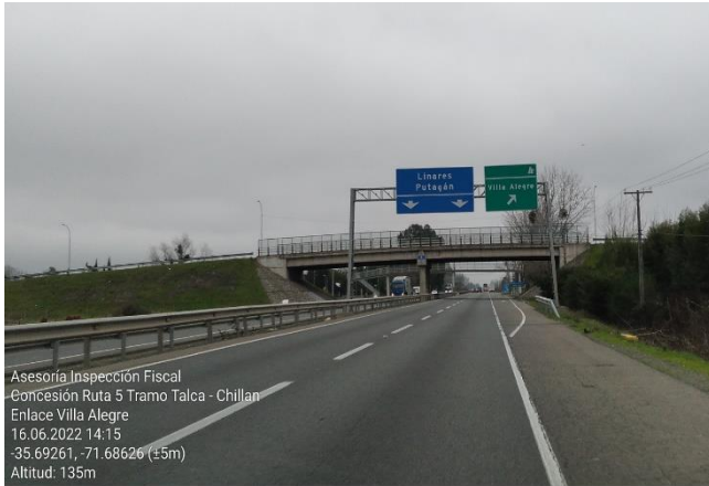
Paso Inferior Villa Alegre (Km 283,900)
